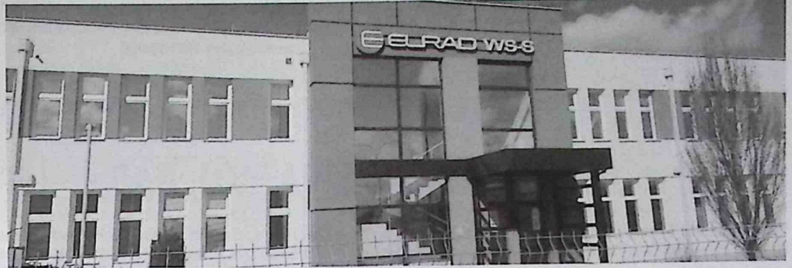
Данашњи изглед једног дела иницијалног језгра индустријске зоне Власотинца. На слици: Фабрика „Елрад“ настала приватизацијом погона Фабрике „Специфични елементи“, која је извршила проширење и модернизацију пословног простора. Поред иницијалног језгра подигнути су нови производни капацитети...
