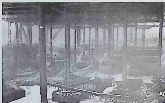
Сл. 25. Водени тогон у Фабрици џајтана у Вучју. Сваки чекрк има власити тогон. Фотографија из књиге Ђ. Ситанојевића - „Електрична индустрија у Србији”, Београд 1901.
